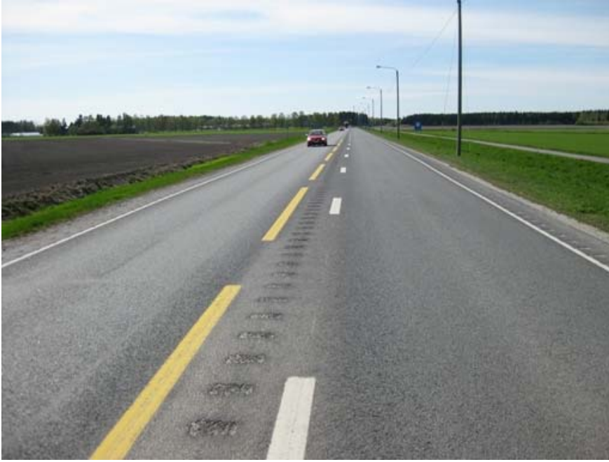
Kuva 3 Laihian leveän keskimerkinnän jyrinnät tehtiin samaan tapaan kuin Noormarkussa, mutta ajokaistan leveys oli keskimäärin n. 0,2 m leveämpi kuin Noormarkussa.
