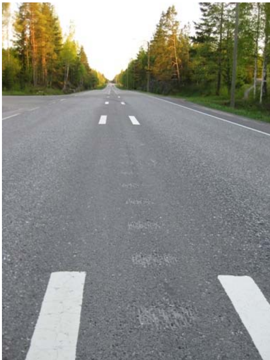
Kuva 2 Noormarkussa käytettiin sylinterijyrsintää. Jyrsintä tehtiin pääosin tien keskilinjan kohdalle. Ainoastaan kaksoissulkuviivojen kohdalla tehtiin vierekkäiset jyrsinnät. Laitilan ja Laihian koeteistä poiketen reunaviivojen kohdalla ei ollut jyrsintää.
