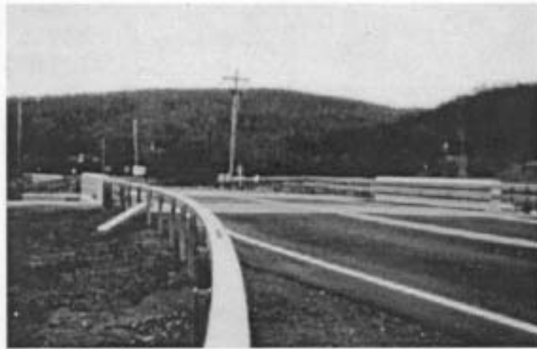
Kuva 17. Valmis silta avattuna juuri liikenteelle / 18 /.
