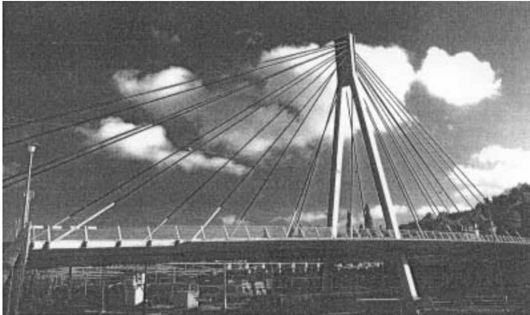
Kuva 19. Storchenbrücken silta Sveitsistä / 10 /.
