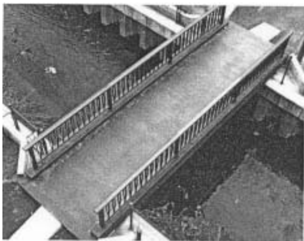
Kuva 11. Japanilainen kävelysilta jännitettyä hiilikuitujänteillä / 10 /.
