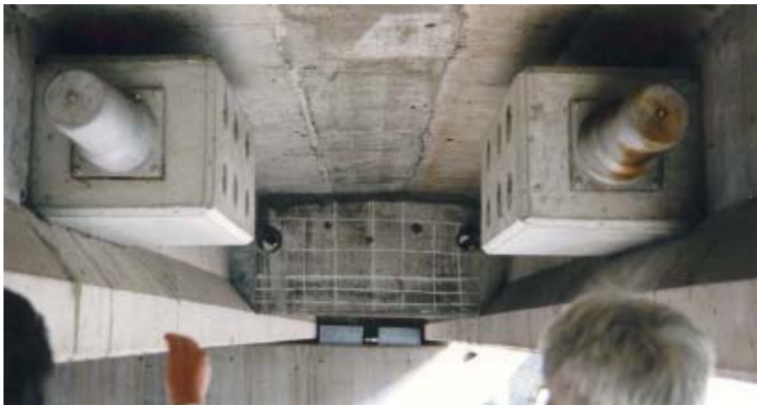
Kuva 14. FRP-jäniteitä käytetty konsolien kiinnityksessä / 30 /.
