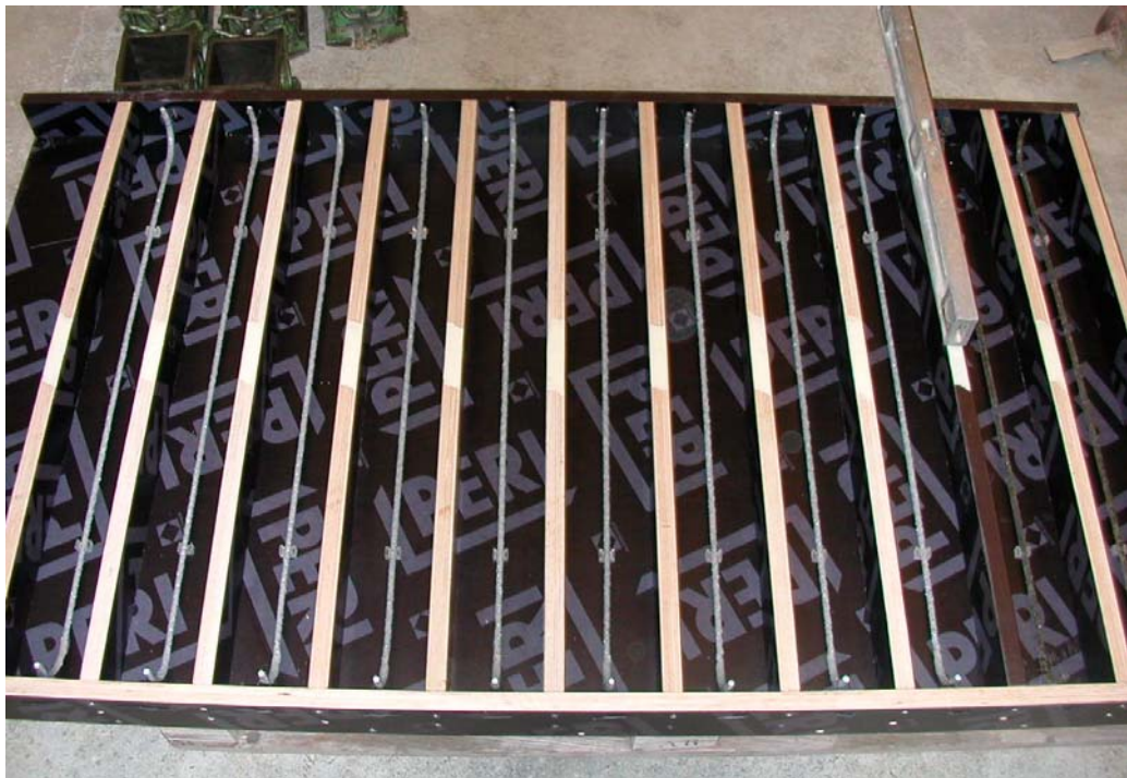
Kuva 3. Koepalkkien valun muottivaihe.
