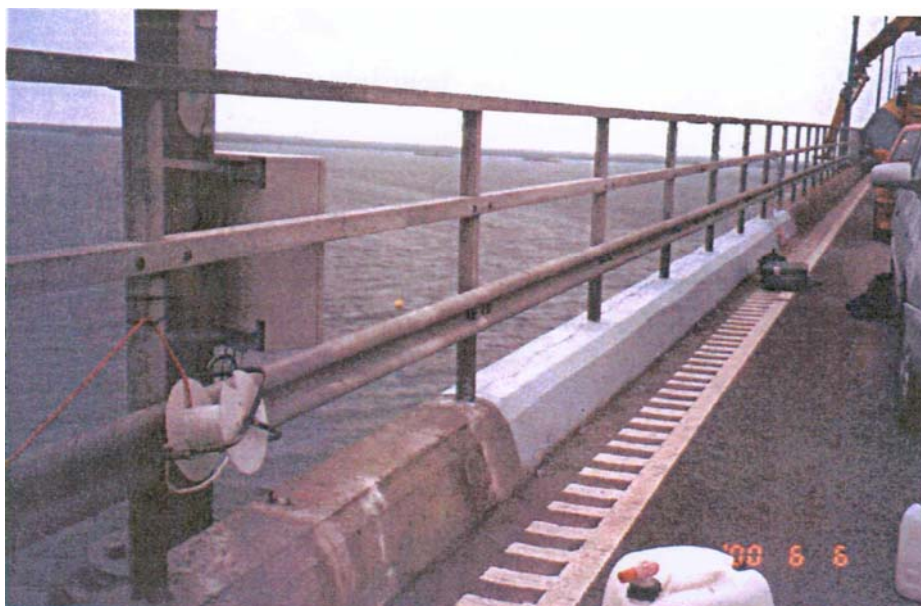
Maalaamalla kiinnitetty grafiittikangasanodi. (Korrosionsinstitutet) Fastmålad ytanod av grafitduk. (Korrosionsinstitutet) Graphite cloth surface anode fixed on paint coating. (Korrosionsinstitutet)
