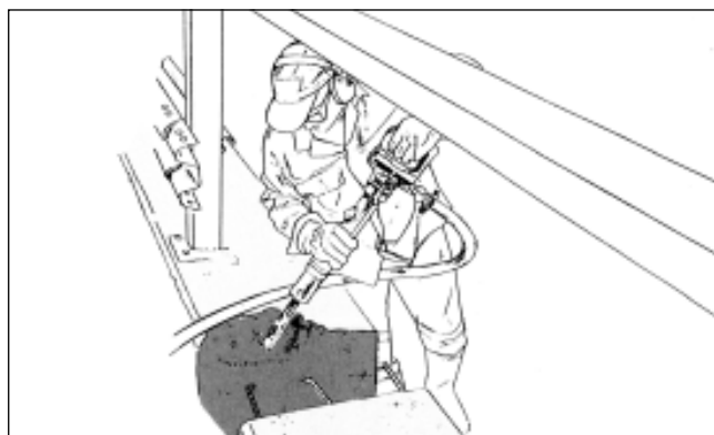
Kuva 8. Pieniä alueita voidaan purkaa piikkausvasaralla.
