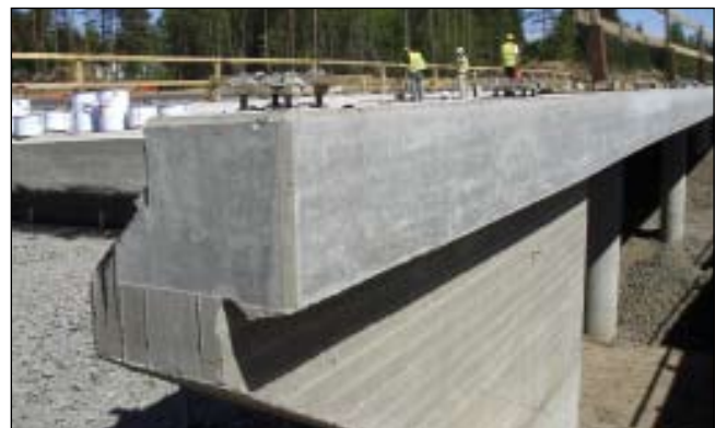
Kuva 12. Muottikangasta vasten valettu pinta.
