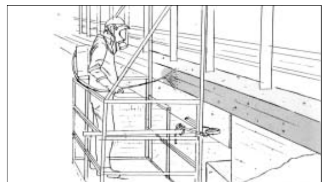
Kuva 18. Reunapalkin suojausta impregnoimalla.
