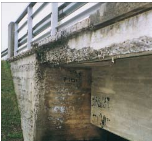
Kuva 2. Rapautuminen on edennyt niin pitkälle, että reunapalkki on uusittava.
