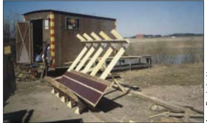
Kuva 9. Kaiteen varaan asennettava muottielementti.
