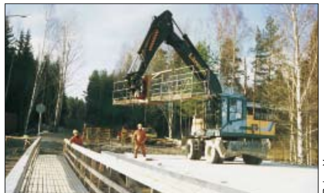
Kuva 11. Muottien asentamiseen ja purkamiseen sopiva nostokori.
