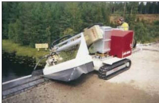
Kuva 6. Reunapalkkia puretaan vesipiikkausella, mikä on suositeltavin purkamismenetelmä.
