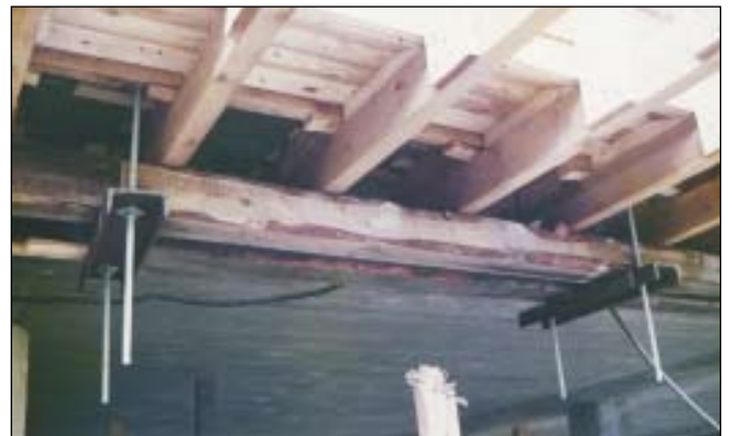
Kuva 10. Tippuputkien läpi ripustettu muotti.
