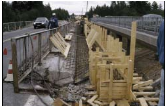
Kuva 4. Suojakaide työskentelyalueen ja ajoradan välissä.
