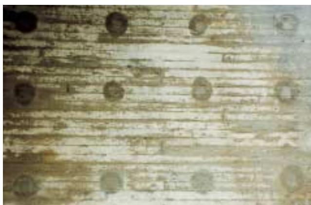
Kuva 3. Häiritsevästi erottuvia paikkauksia.
