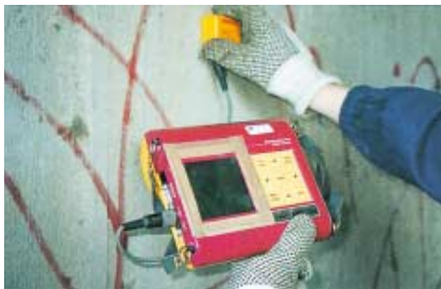
Kuva 5. Raudoitustankojen paikat määritetään.
