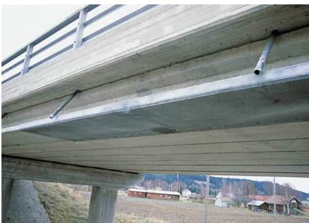
Kuva 7. Törmäysvaurion korjauksessa käytetty teräsmuotti on jätetty paikalleen.
