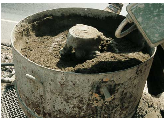
Kuva 8. Betoni sekoitetaan pakkosekoittajassa.
