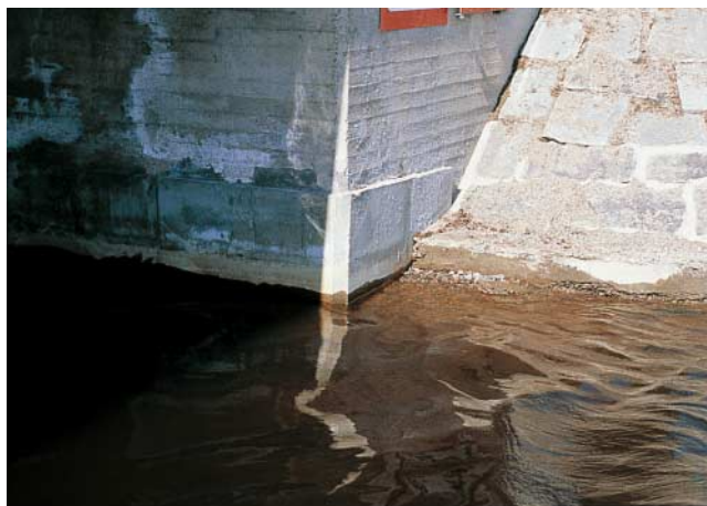
Kuva 3. Kuivatyönä tehty maatuen manttelointi.
