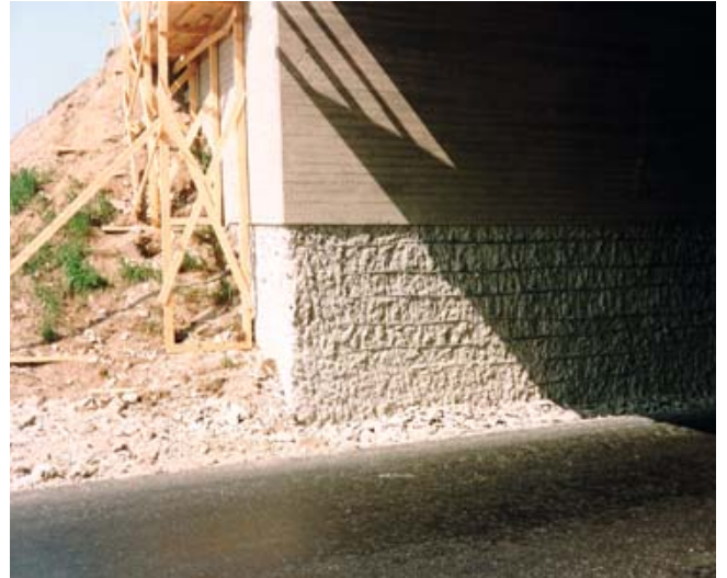
Hyvin rajattu ruiskubetonoitava alue.
