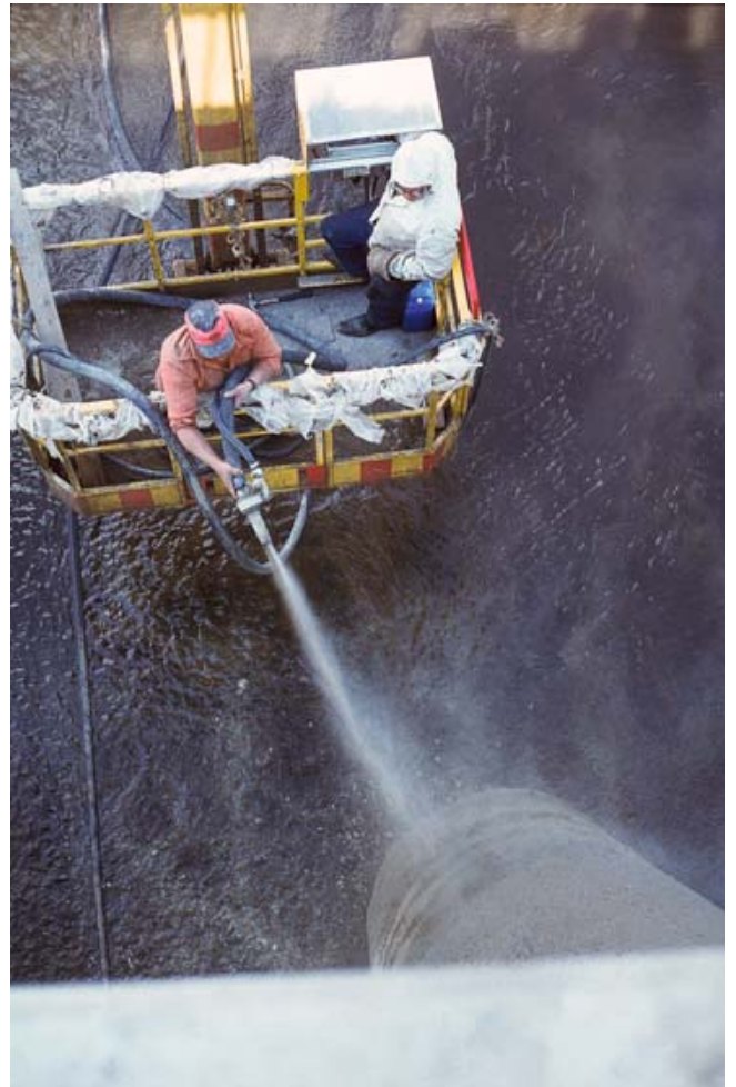
Kuva 4. Pilarin ruiskubetonointia siltakurjen korista käsin.
