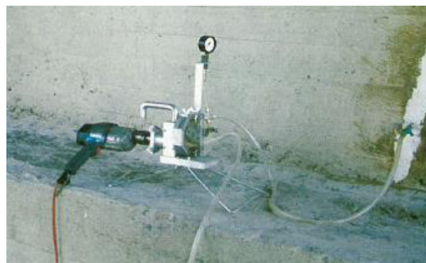
Kuva 3. Injektointilaitte ja suutinpainemittari.
