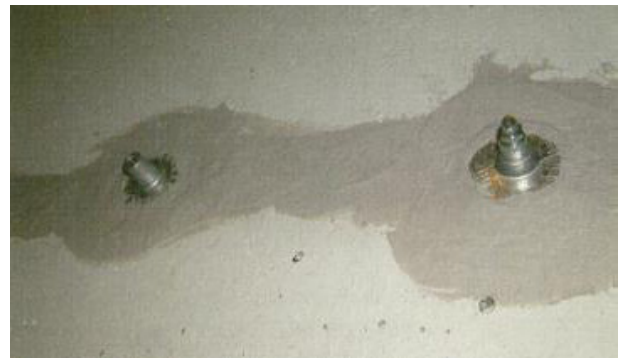
Kuva 8. Aluslevyjä ja toiseen kiinnitetty injektointinippa.
