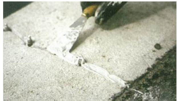
Kuva 6. Sulkuaine levitetään lastalla.
