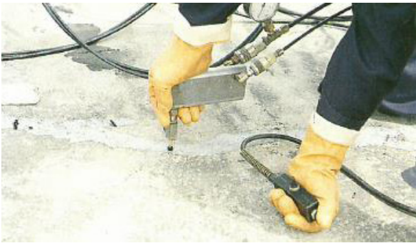
Kuva 4. Injektointilaitte, jossa komponentit sekoittuvat vasta suuttimessa.
