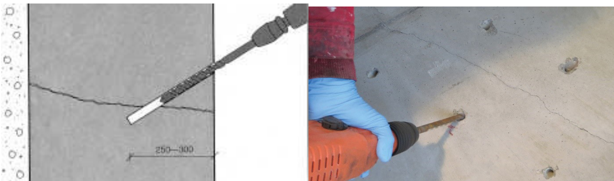
Kuva 10. Reiät porataan siten, että ne leikkaavat halkeaman.
