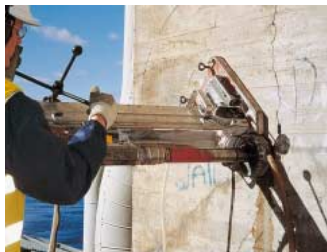
Kuva 4. Ennakkokokeen tulos tarkistetaan rakenteesta porattavasta näytteestä.
