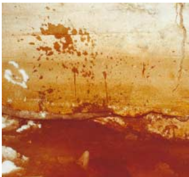
Kuva 1. Liian suuren maanpaineen aiheuttamia halkeamia.
