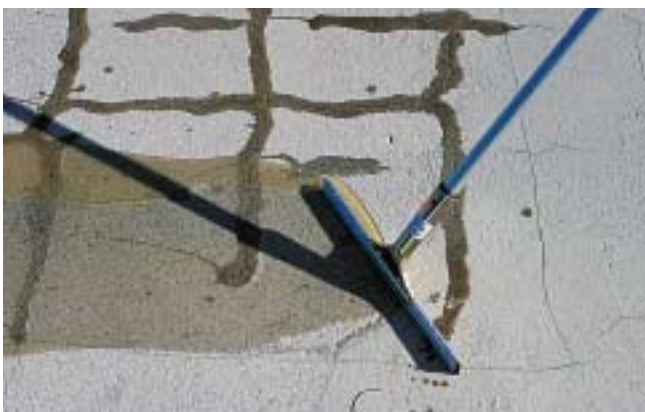
Kuva 6. Eristysalustan epoksiivistyksen yhteydessä tehtävä imeytys tehdään joko pelkästään lastalla levittämällä tai lastalla halkeamien esikäsitteilyn (vaiheet 1 ja 2) jälkeen (vaihe 3).
