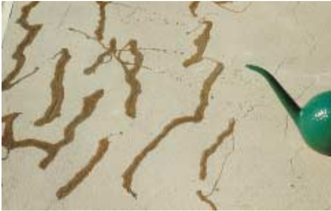
Kuva 4. Imeytysaine on kaadettu halkeaman päälle (vaihe 1).
