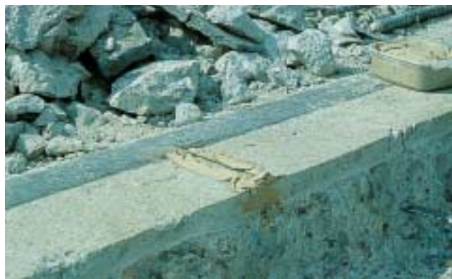
Kuva 11. Halkeaman kohdalle tehdään kaukalo.
