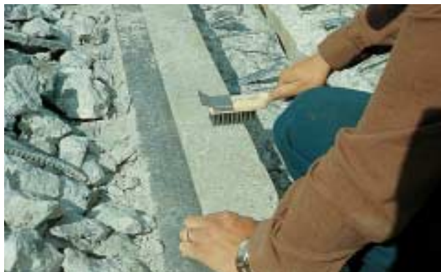
Kuva 10. Halkeaman pinta puhdistetaan.
