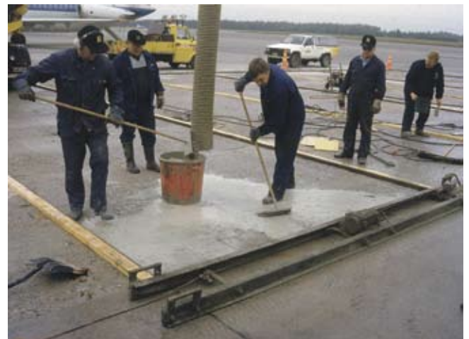
Kuva 7. Tartunta-aine levitetään harjaamalla.
