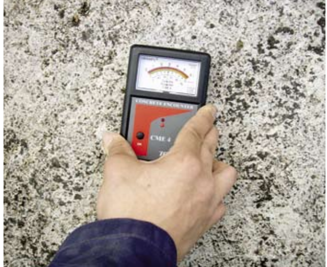
Kuva 15. Betonin absoluuttisen kosteuden mittaus.
