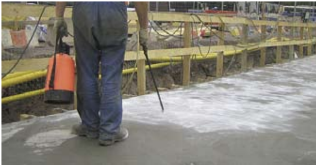
Kuva 10. Jälkihoitoaine levitetään ruiskulla.
