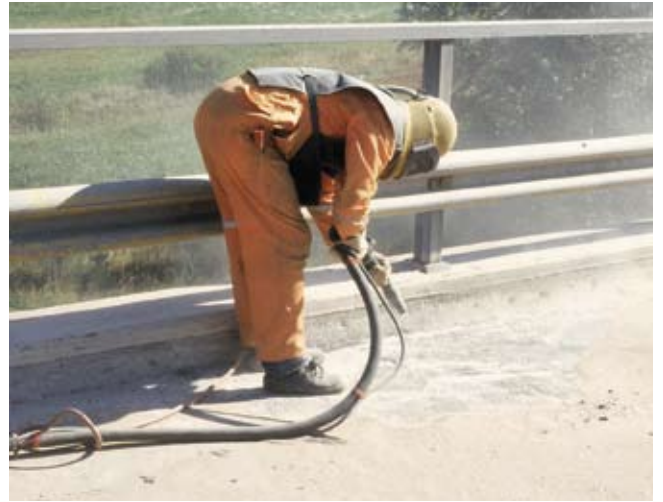
Kuva 12. Eristysalustan suihkupuhdistusta hiekkapuhalluksella.
