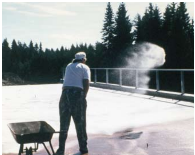
Kuva 17. Sirotteen levitystä tuoreen epoksin pinnalle.
