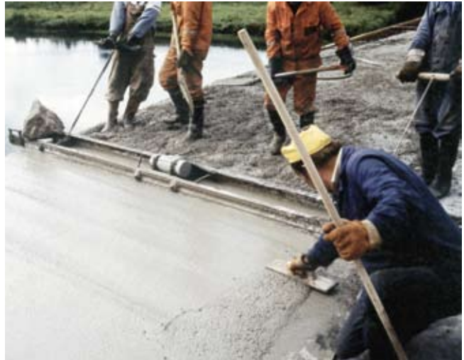
Kuva 8. Betonimassa tiivistetään tärypalkilla.
