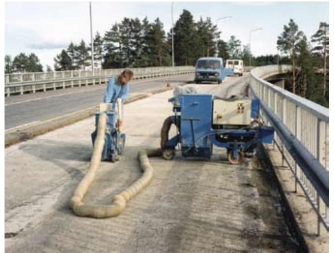
Kuva 13. Eristysalustan suihkupuhdistusta sinkopuhdistuksella.
