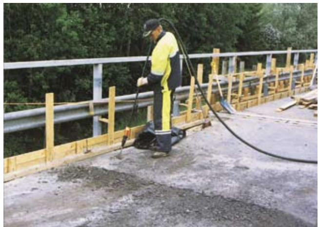
Kuva 11. Vanha kermieristys poistetaan petkeleellä.
