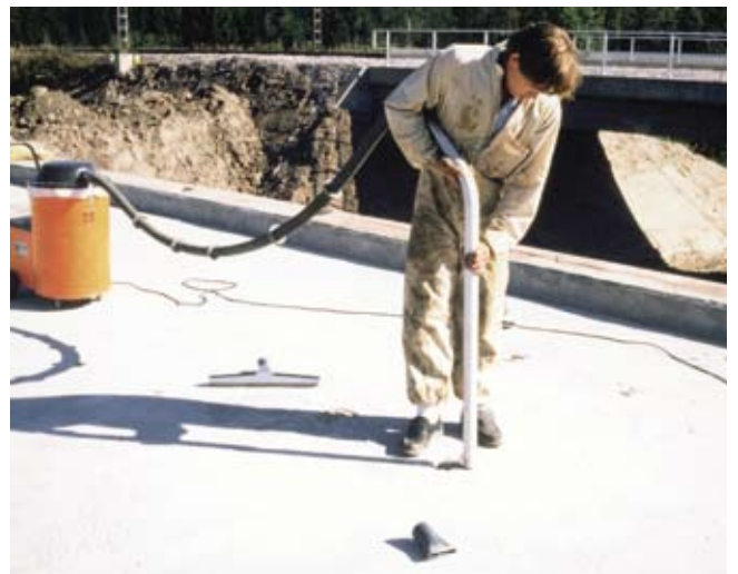
Kuva 14. Lopuksi eristysalusta puhdistetaan imuroimalla.
