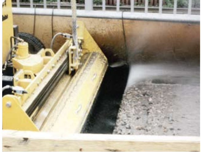
Kuva 3. Kansilaatan vesipiikkausta.
