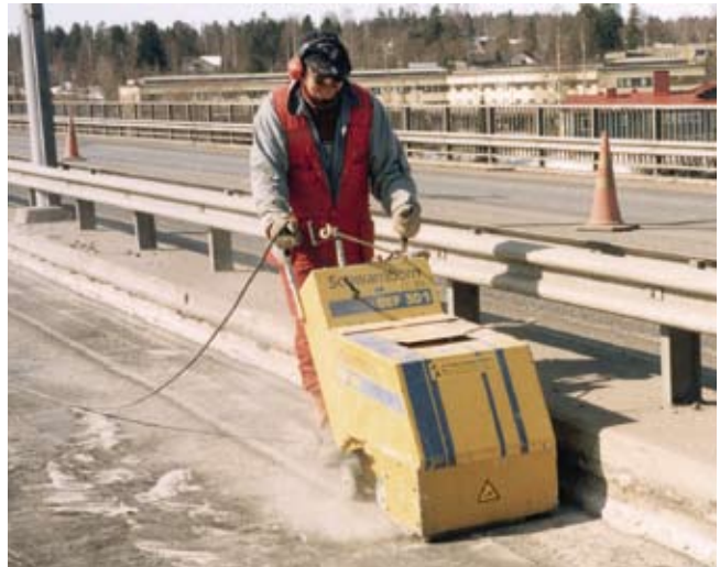
Kuva 4. Kansilaatan pintaa poistetaan voimakkaalla jyrshintä.
