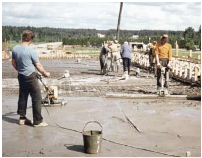
Kuva 9. Pinta hierretään heti, kun muotoiluvalu kantaa koneen.
