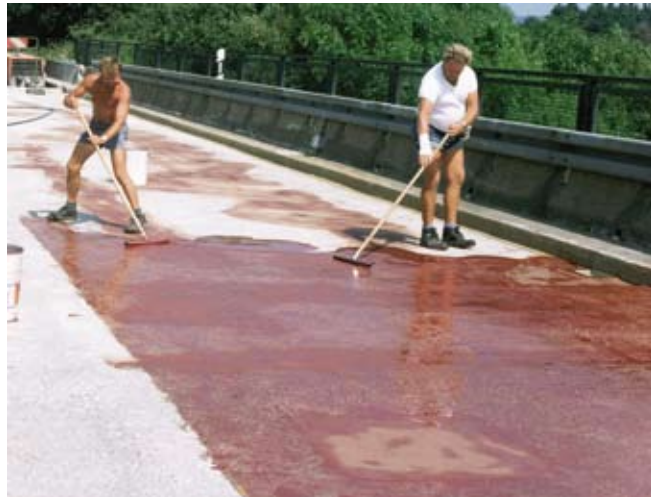
Kuva 16. Epoksin levitystä.
