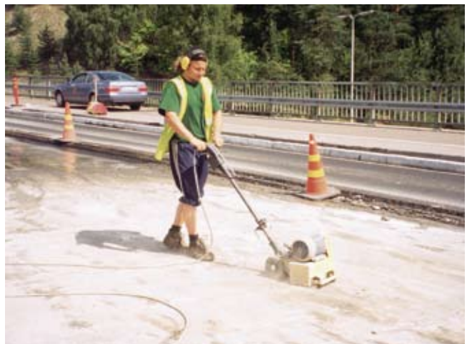
Kuva 5. Pienet alueet jyrshintä ja jälkijyrshintä tehdään kevyellä jyrshintä.
