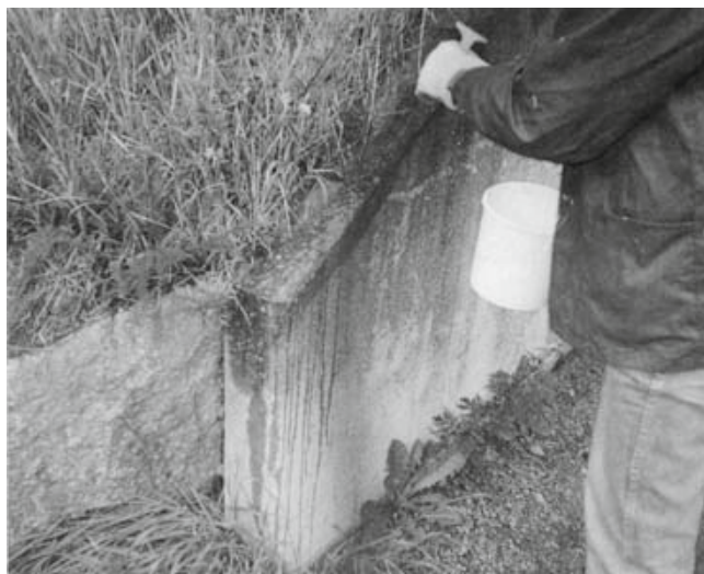
Kuva 16. Kasvinpoistoliuosta levitetään siipimuurin pinnalle.
