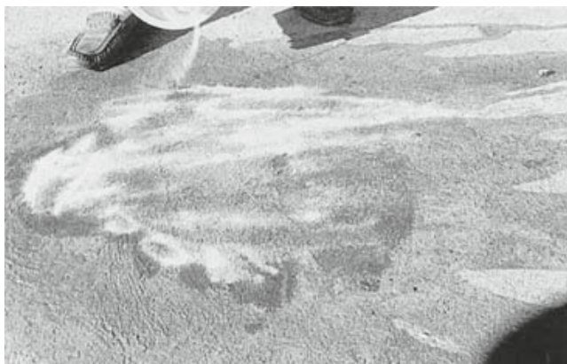
Kuva 5. Öljynpoistoaine levitetään märälle pinnalle.
