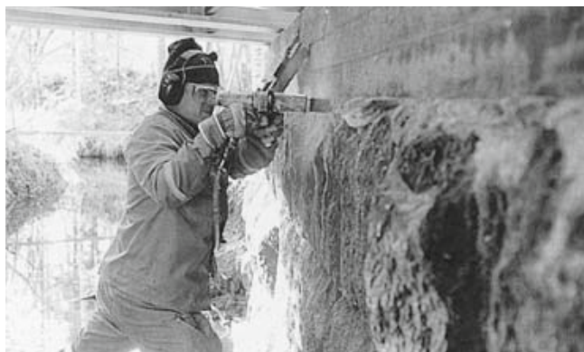
Kuva 10. Kivipintaa puhdistetaan neulahakkurilla.
