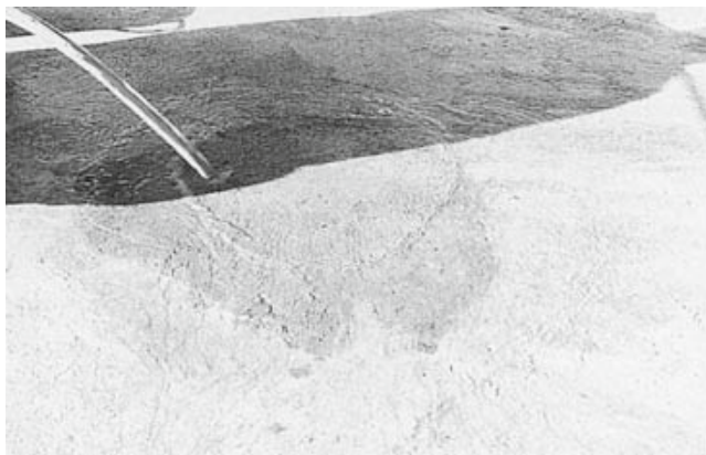
Kuva 6. Liuos huuhdellaan pois runsaalla vedellä noin puolen tunnin ajan.
