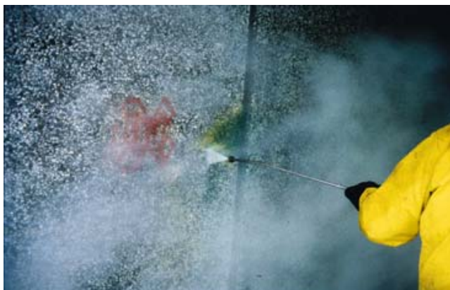
Kuva 14. Pinnan pesu suurpainepesurilla on päättymässä.
