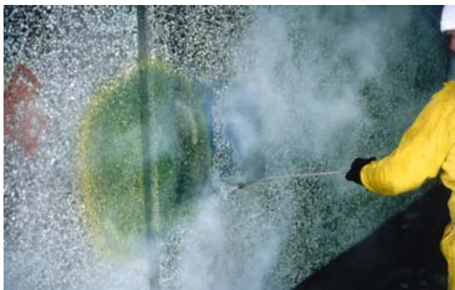
Kuva 13. Pinnan pesu suurpainepesurilla on alkamassa.
