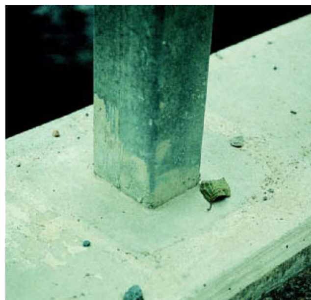
Kuva 8. Varaukseen juotettu kaidepylväs, jonka juurikoroke on muotoiltu lastan avulla.
