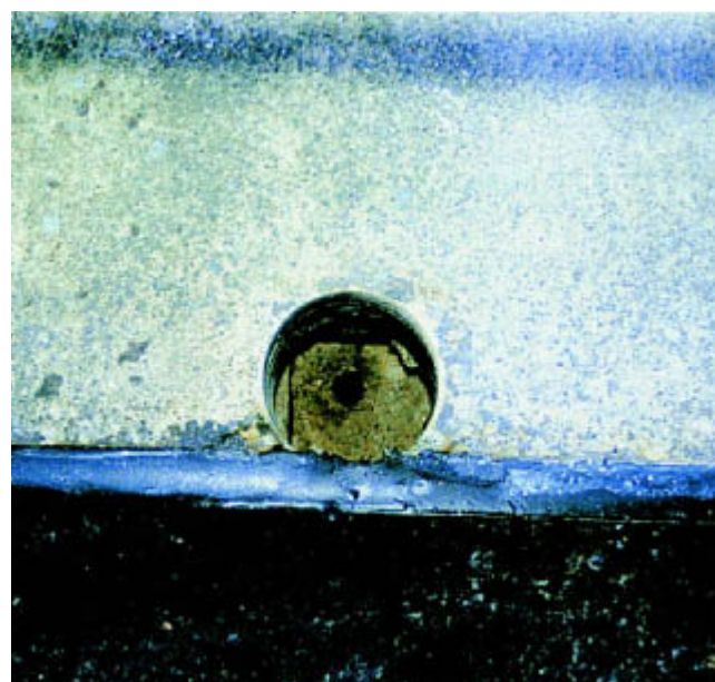
Kuva 6. Vanha kaidepylväs on ollut liian lähellä reunapalkin sisäreunaa.
