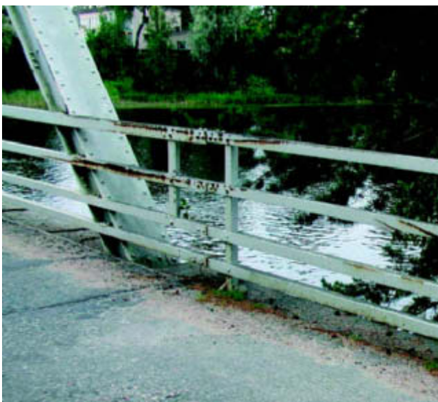
Kuva 1. Raappeet kaiteissa ovat tyypillisiä paikkausmaalauiskohteita.
