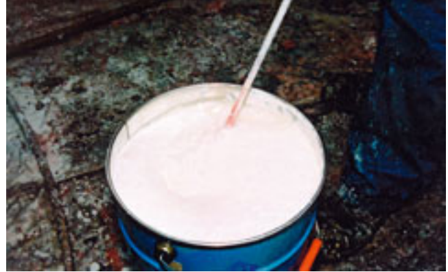
Kuva 5. Maali sekoitetaan huolellisesti.
