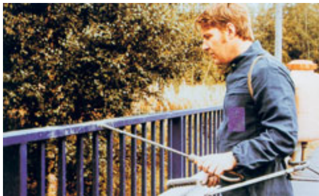
Kuva 3. Maalattavat pinnat pestään.
