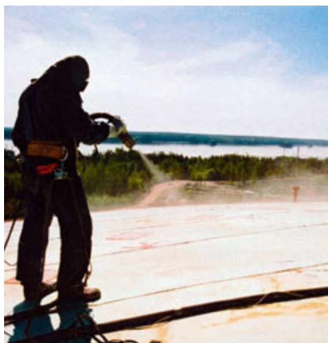
Kuva 4. Maalattava pinta suihkupuhdistetaan.
