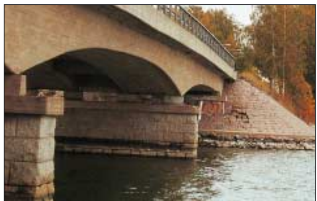
Kuva 11. Välituen laakerit on suojattu kotelolla.
