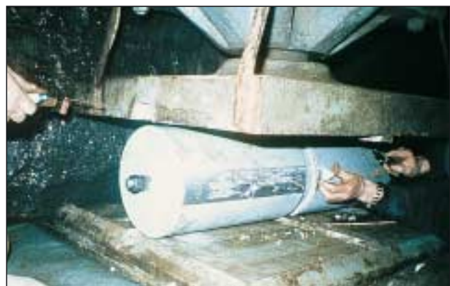
Kuva 10. Irrotetun laakerin asennusta.
