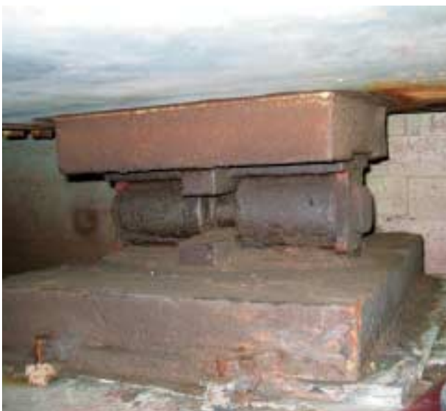
Kuva 2. Kiireellisesti huoltokäsittelyä vaativa laakeri.
