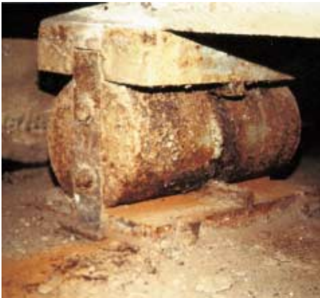
Kuva 1. Puutteellisen esikäsitteilyn vuoksi ruostunut laakeri.
