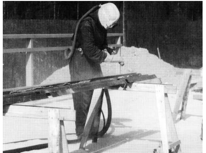
Kuva 4. Pesty pinta suihkupuhdistetaan.
