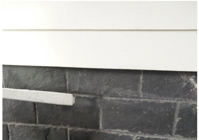
Kuva 2. Kivipinnan puhdistusta kuivajääpuhalluksella
