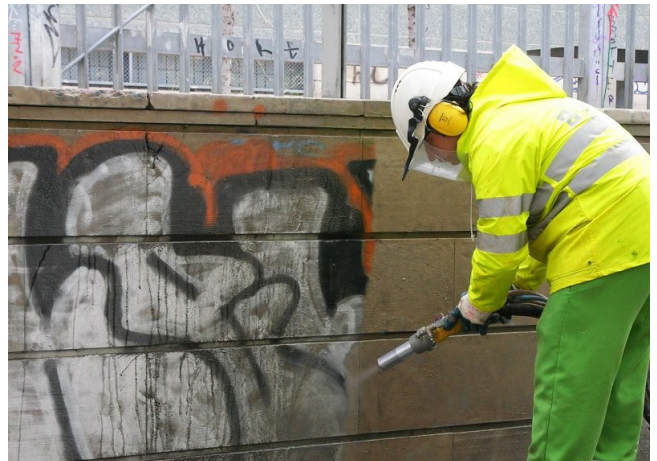
Kuva 3. Töherryksen poisto soodapuhalluksella.
