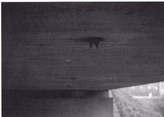
Kuva 1. Vesi leviää liian lyhyen tippuputken ympärille
