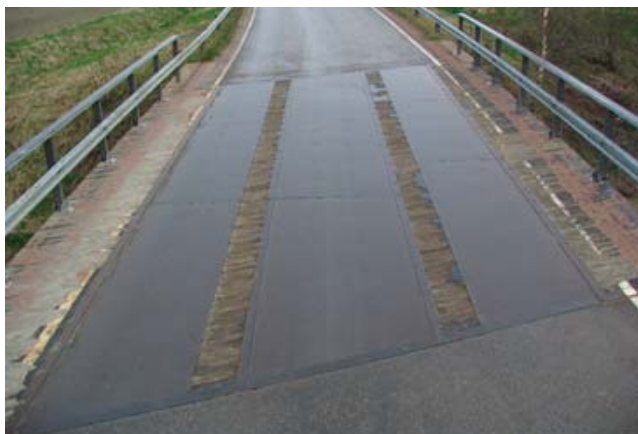
Kuva 3. Teräslevyt puukannelle asennettuina.
