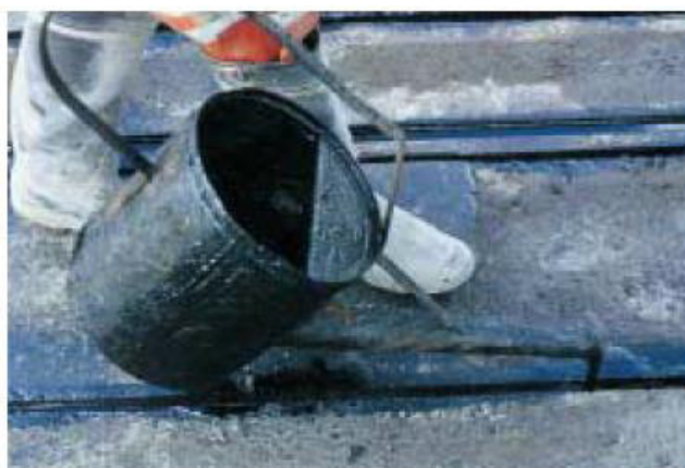
Kuva 9. Halkeaman sulkeminen kannukaatomenetelmällä.
