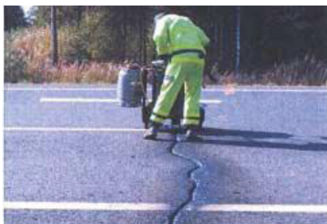
Kuva 8. Halkeaman sulkeminen saumauslaitteella.
