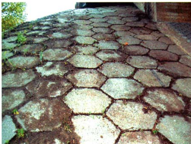
Kuva 2. Betonilaattaverho keilassa.
