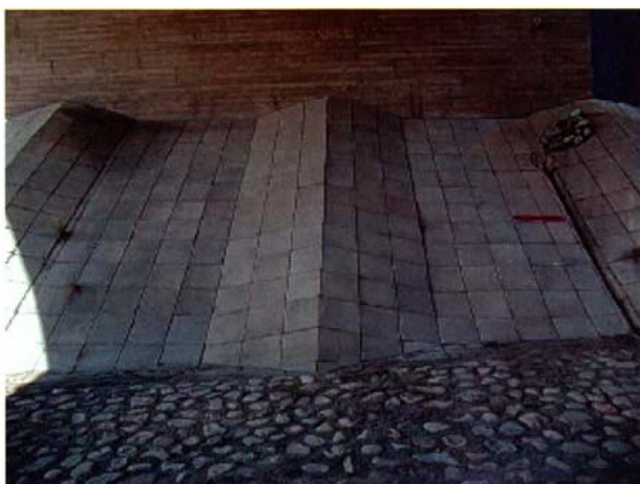
Kuva 1. Betonilaattaverho etuluiskassa.
