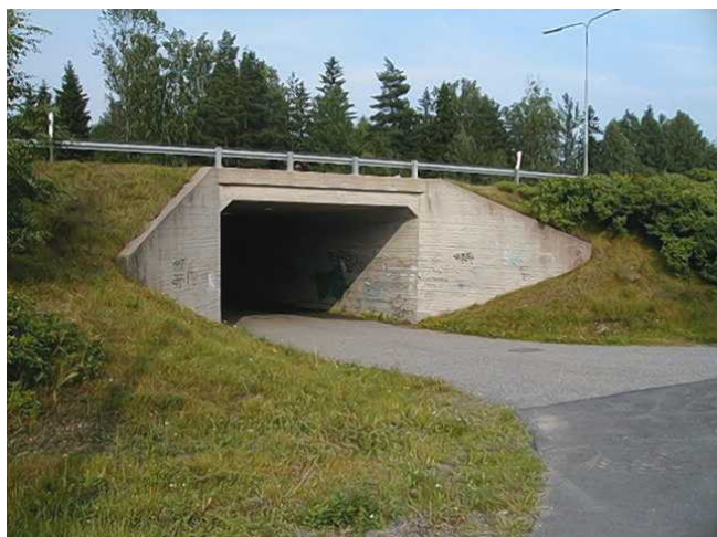
Kuva 1. Siirtonurmikosta tehtyä turveverhousta.
