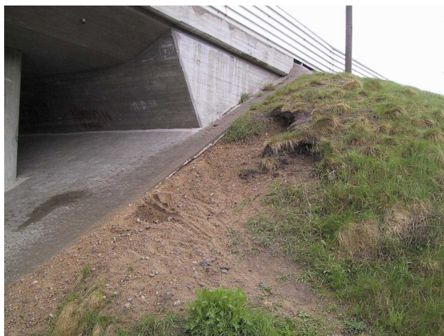
Kuva 2. Turveverhous soveltuu tämänkin rasitetun keilaverhouksen korjaamiseen.
