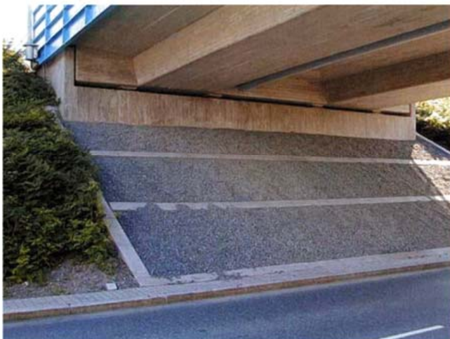
Kuva 2. Sepeliverhouksen valumista on pyritty estämään betonipalkeilla.
