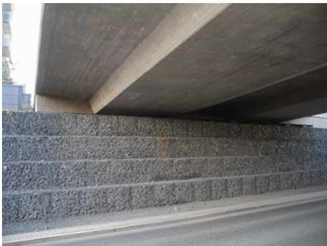
Kuva 1. Kivikoreista tehty tukimuri
