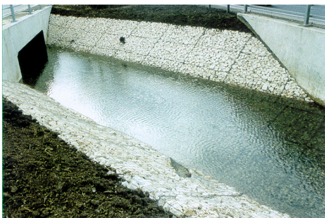
Kuva 2. Kivikoripatja luiskan verhouksena ja uoman pohjan eroosiosuojauksena
