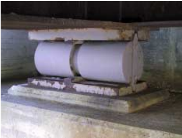
Kuva 2. Laakerin huoltokäsittely on jäänyt puolitiehen
