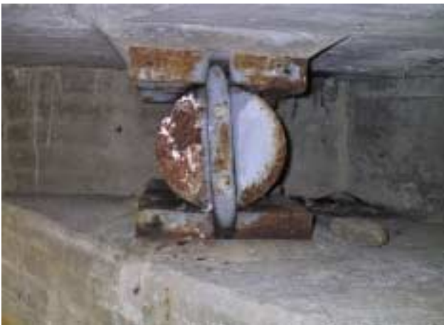
Kuva 1. Huoltokäsittelyn tarpeessa oleva teräksinen rullalaakeri.
