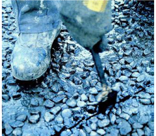
Kuva 6. Päällysteen kutistumissauma (kuumana levitettävä, massatyyppi N2).
