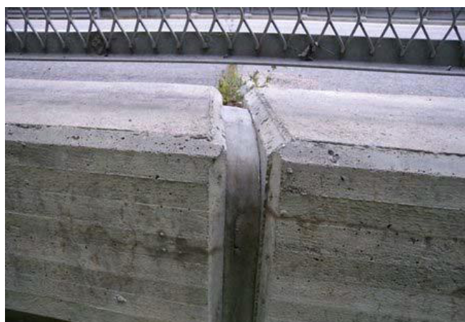
Kuva 2. Alus- ja päällysrakenteen välinen sauma reunapalkin kohdalla.
