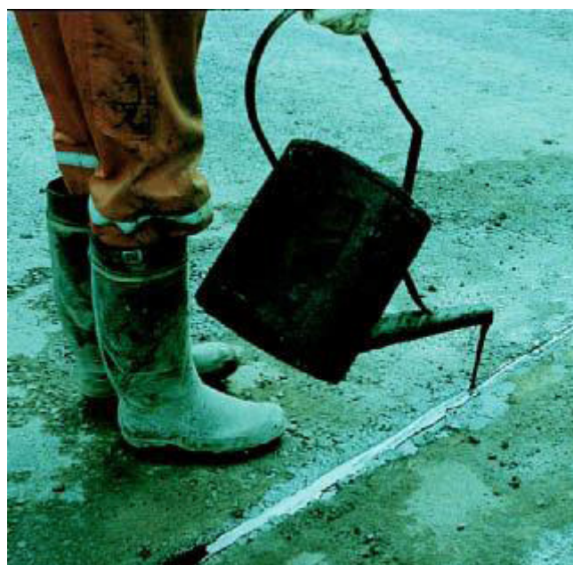
Kuva 3. Päällysteen pienen liikuntasauvan saumausta päällysrakenteen pään kohdalla.
