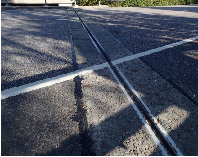
Kuva 4. Tukikaistan ja päällysteen välinen sauma (kuumana levitettävä, massatyyppi N2).
