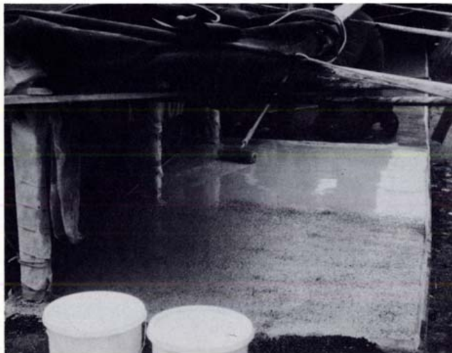
Kuva 1. Jalkakäytävän ohutkerrospäällysteen tekoa
