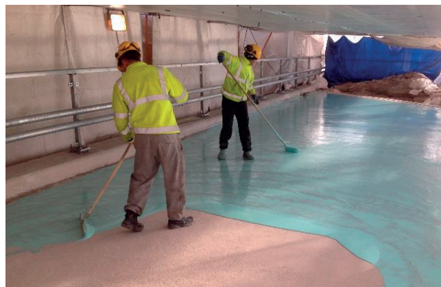
Kuva 1. Tiivistysaine levitetään lastalla ja telataan lastalevityksen jälkeen.
